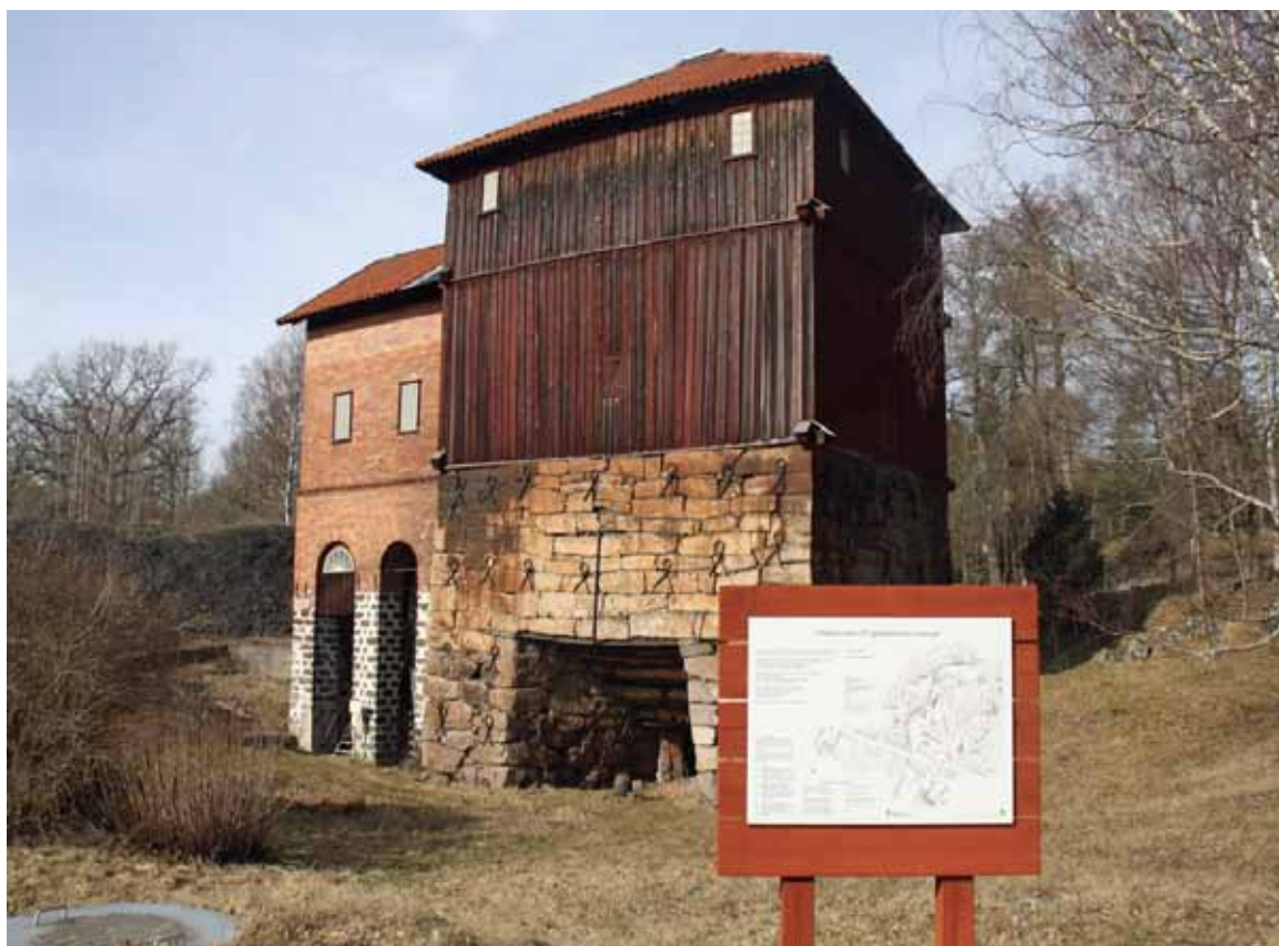
Masugnen i Igelbäck - ett ståtligt byggnadsverk som minner om industrin förr i bygderna. Bra informationstavlor berättar ingående om platsen. Utnäset ligger invid.
