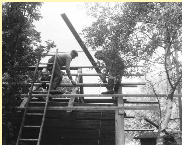
Taket läggs på handelsboden, nuvarande Ledcentralen.
